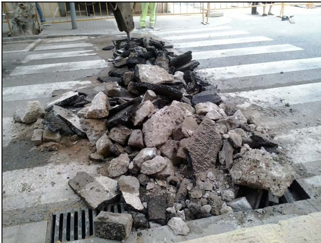
Fotografia núm. 3: obertura de la rasa 1000
