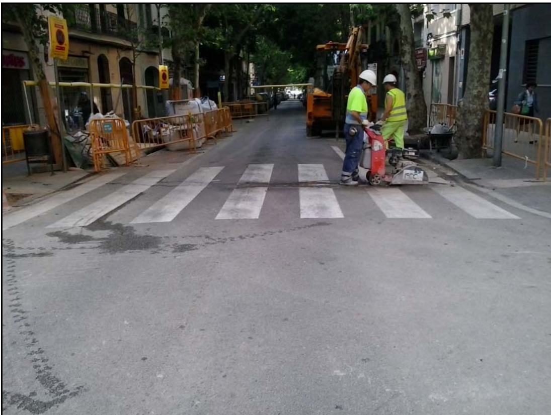
Fotografia núm. 2: obertura de la rasa 1000
