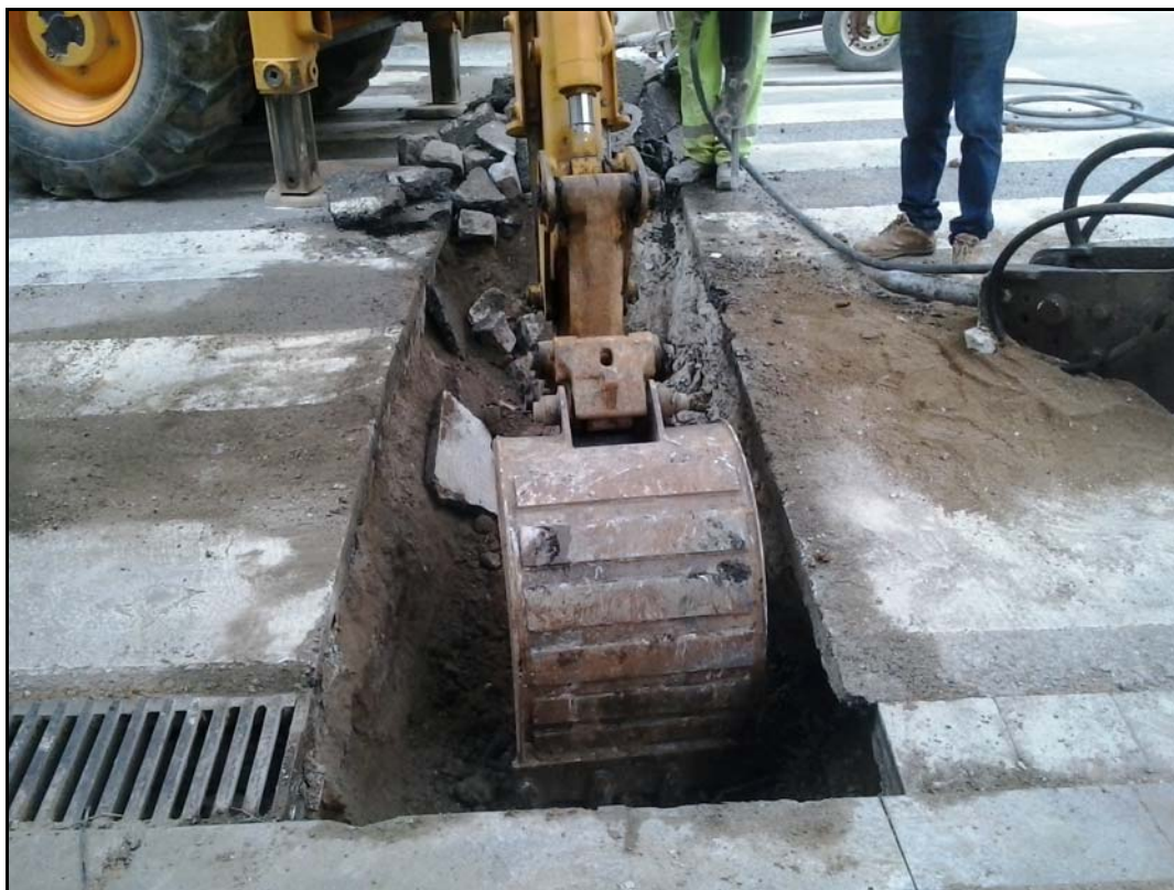
Fotografia núm. 5: obertura de la rasa 1000
