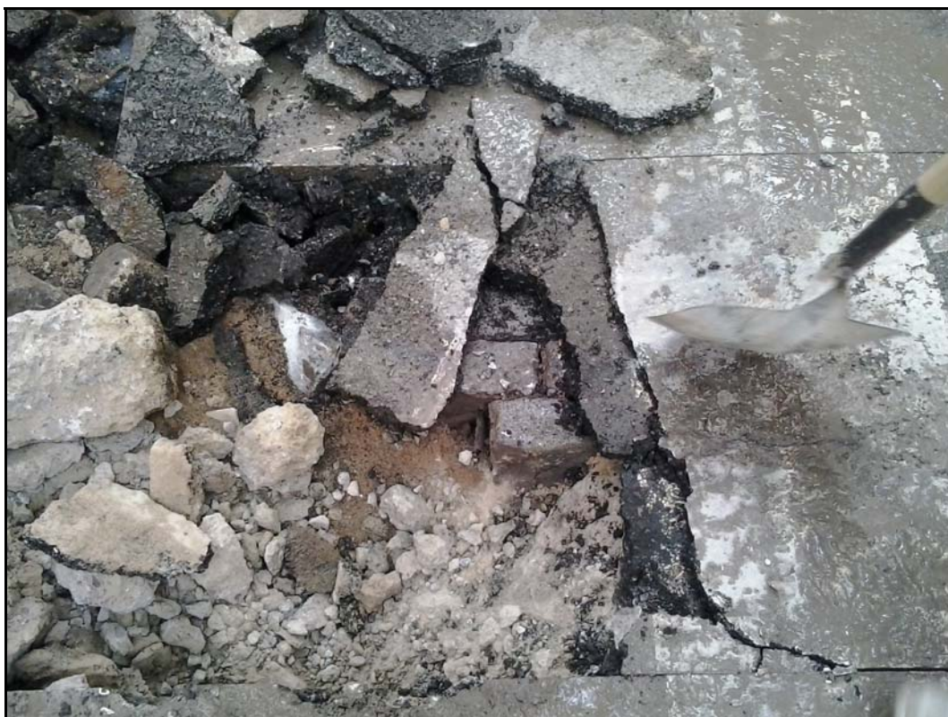
Fotografia núm. 4: antic paviment de llambordes del carrer Vallespir
