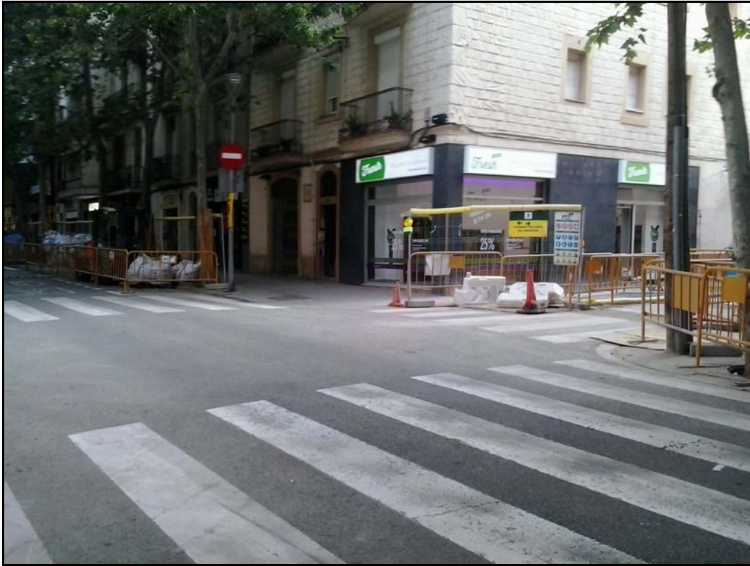
Fotografia núm. 1: àrea intervinguda a l'inici dels treballs
